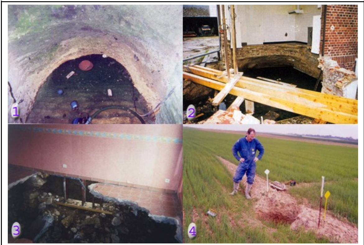
Fig.3 : 1 : Situation en avril 2002 d'une cave – 2 et 3 : Effondrements du sous-bassement des habitations – 4 : Débourage d'une marnière dans un champ
